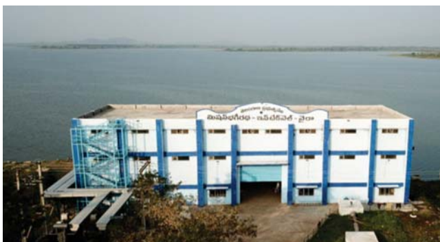
70 MLD WTP (Wyra – Jurala Segment)
